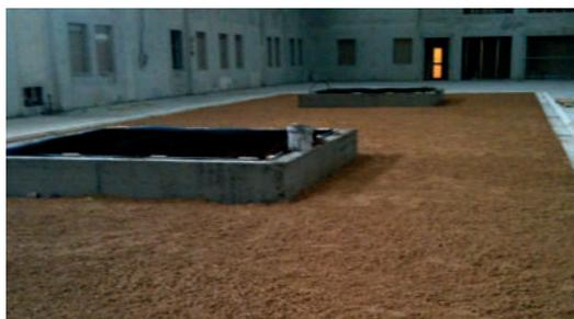
**PREPARAZIONE DEL FONDO:** livellare il terreno con delle leggere pendenze per il deflusso dell'acqua, poi costipare con una buona rullatura.
